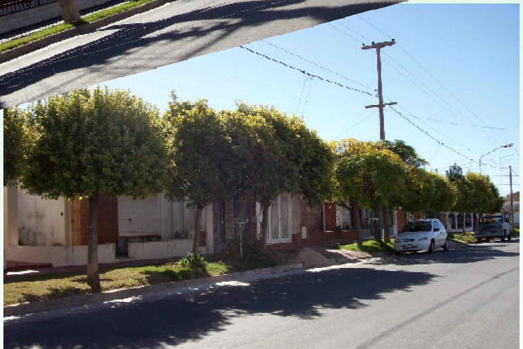
Barrio Luz y Fuerza I. 30 viviendas, las últimas de las cuales fueron entregadas en de marzo de 1972.
